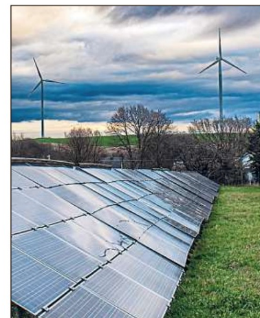
In Verl sollen Freiflächen-Photovoltaik-Anlagen entstehen.
