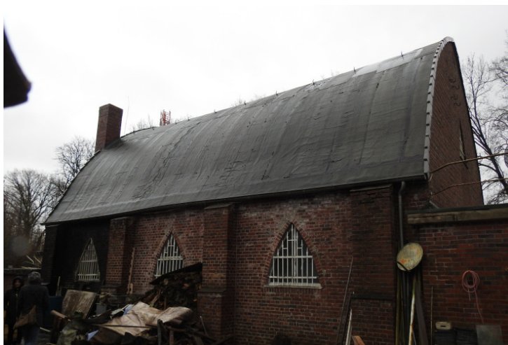
Ansicht der weitgehend bauzeitlich überlieferten nördlichen Traufseite.
