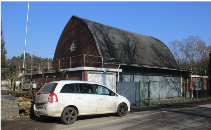
Ansicht der südlichen Traufseite mit später eingesetzten Metalltoren, der südwestlichen Giebelwand mit verkleinertem Giebelfenster und angebauter Garage sowie dem prägenden Zellendach.
