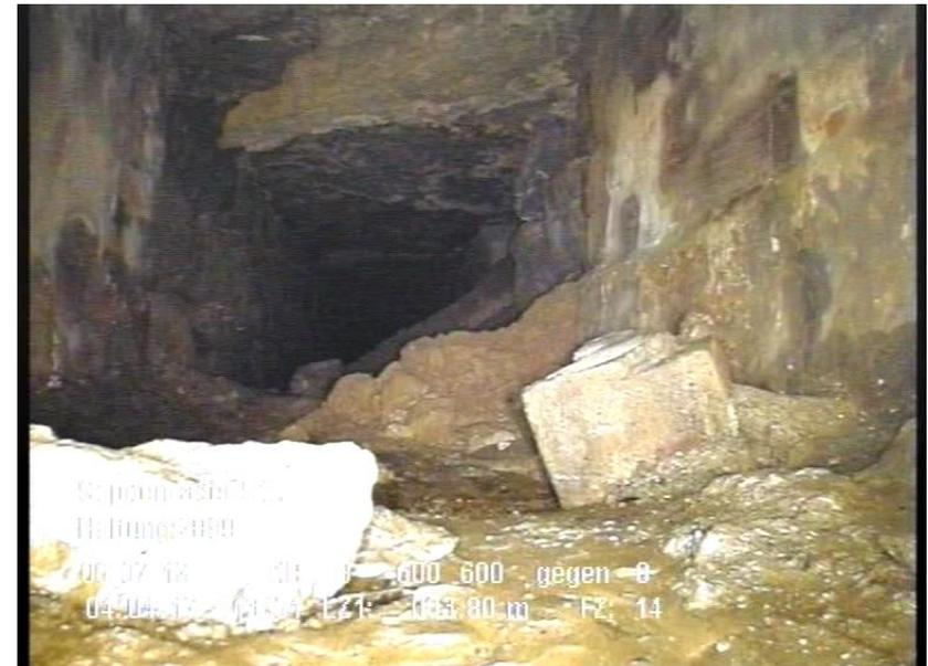
Rohrbruch/Einsturz, fehlende Teile, (04 - 08), L =999mm
