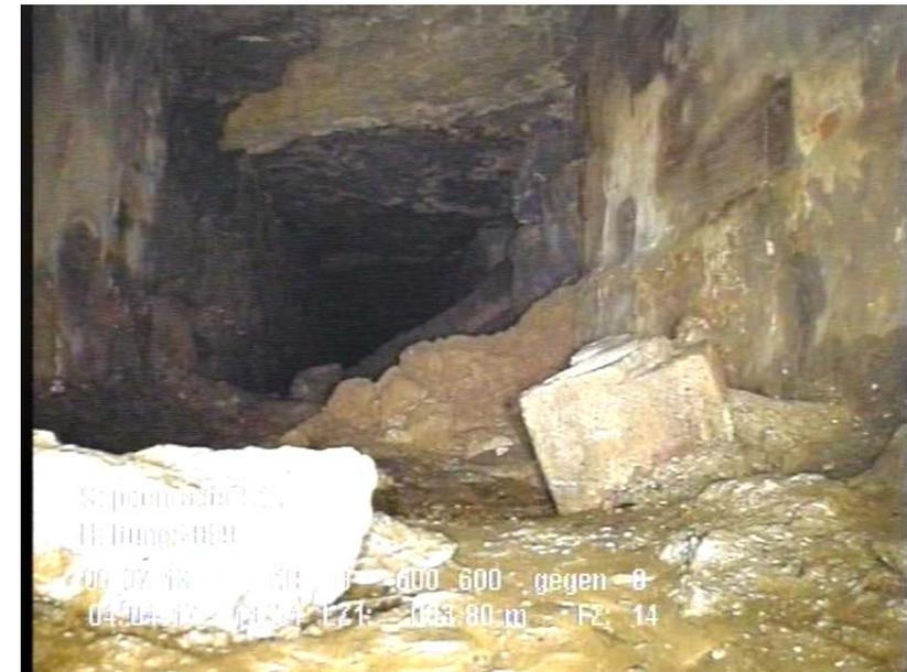
Rohrbruch/Einsturz, fehlende Teile, (04 - 08), L =999mm
