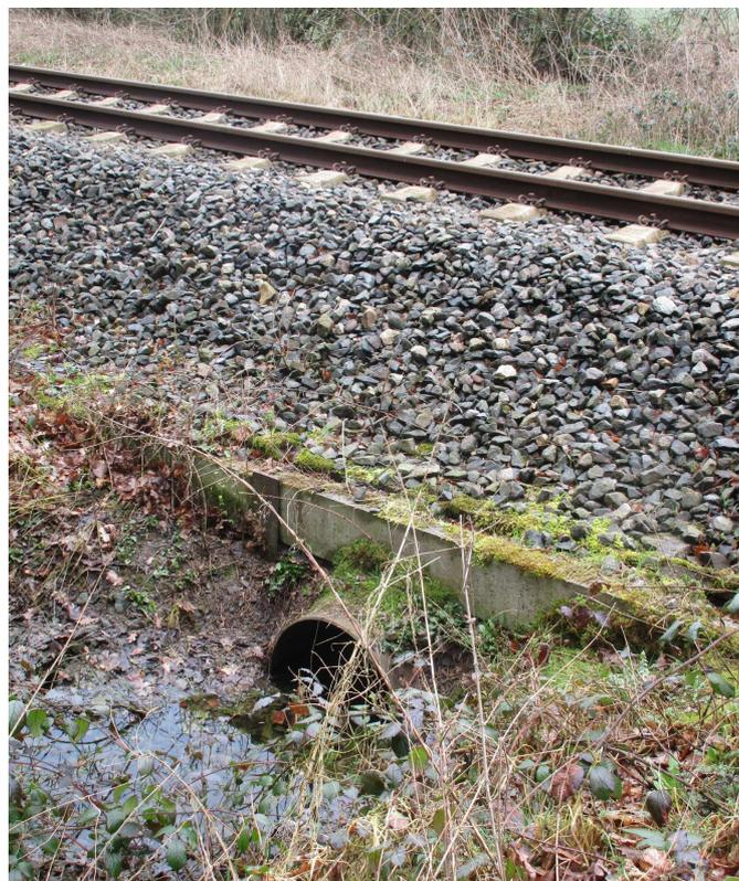
Abb. 6: Der für die Entwässerung entscheidende Durchlass unter der Bahnlinie für den Buschkämpegraben; auch hier gut zu sehen die geringe Eintiefung
