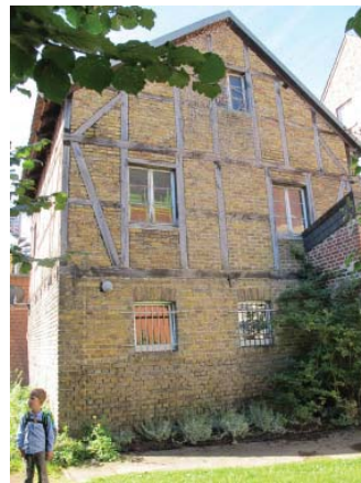
In Fachwerk errichtete Ost- und Nordfassade
