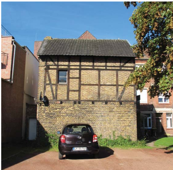
In Fachwerk errichtete Ost- und Nordfassade
