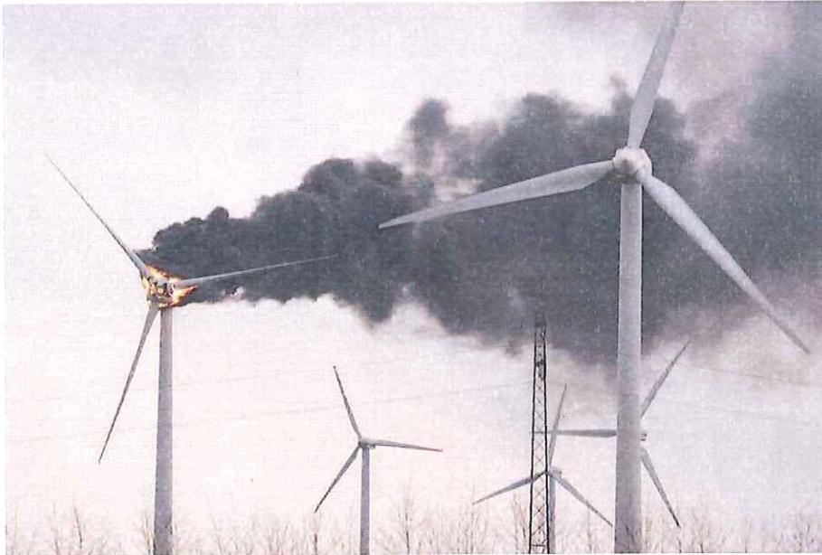
Abb.14: Im Windpark Oederquart nahe der Elbmündung gab es am 4.4.2016 einen typischen Brand im Maschinenhaus einer 70 m hohen WKA. Die Feuerwehr musste tatenlos zuschauen.
