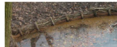
Bündel aus Weiden- und Erlenruten ahmen ein natürliches Ufer nach: Die Zweige brechen die Wucht des Wassers, sie filtern zudem Sand aus und gleichen damit Verluste durch Erosion aus. Die Zweige sind in der Lage (wie Ableger) anzuwachsen. Damit wächst das Geflecht immer wieder nach.
