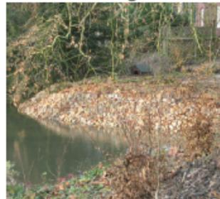
Steinschüttungen setzen dem Wasser hohen Widerstand entgegen. Die einzelnen Steine teilen zudem den Wellenangriff. Allerdings müssen Steine und Untergrund weiter gegen Abrutschen gesichert sein, sonst versinken die Steine im Teichgrund und das Ufer ist ungesichert.
