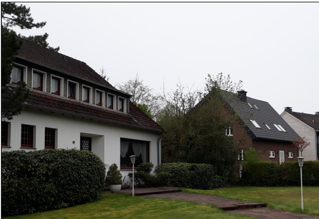
Abb. 6: Bestandsgebäude im Geltungsbereich
